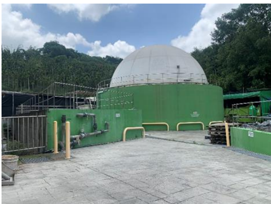
★新合興牧場「二階段高效厭氧發酵技術」處理養豬廢水的沼氣發電工程
