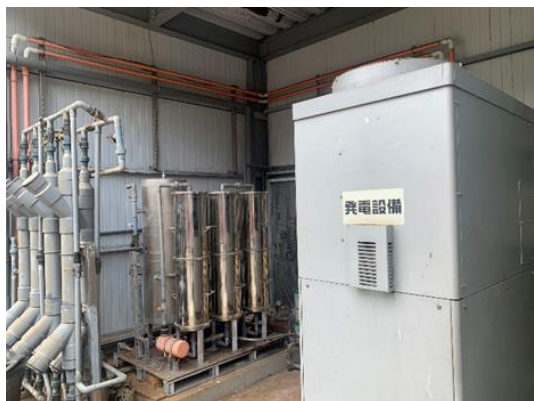
★新合興牧場「二階段高效厭氧發酵技術」處理養豬廢水的沼氣發電工程
