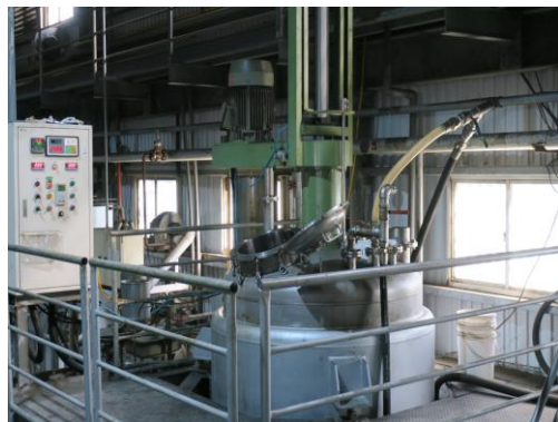
高速乳化均質設備
