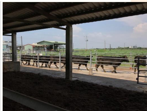
進牛作業施作情形
